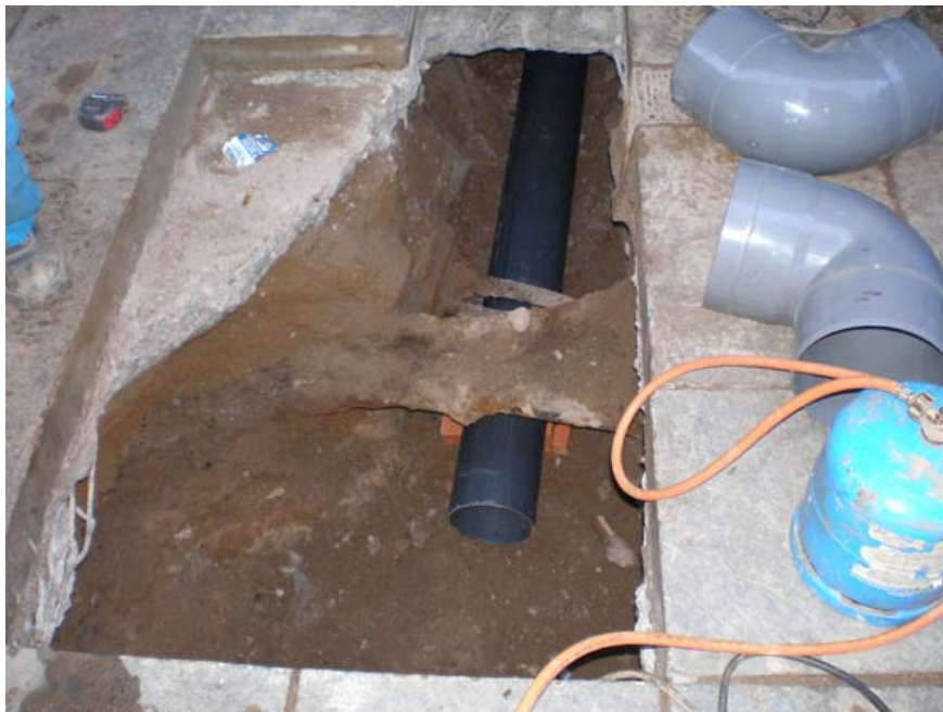
Detall del procés de col·locació del tub.
