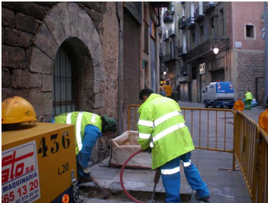
Operaris de la Unitat Operativa de Sanejament de l'Ajuntament de Barcelona obrint la rasa.
