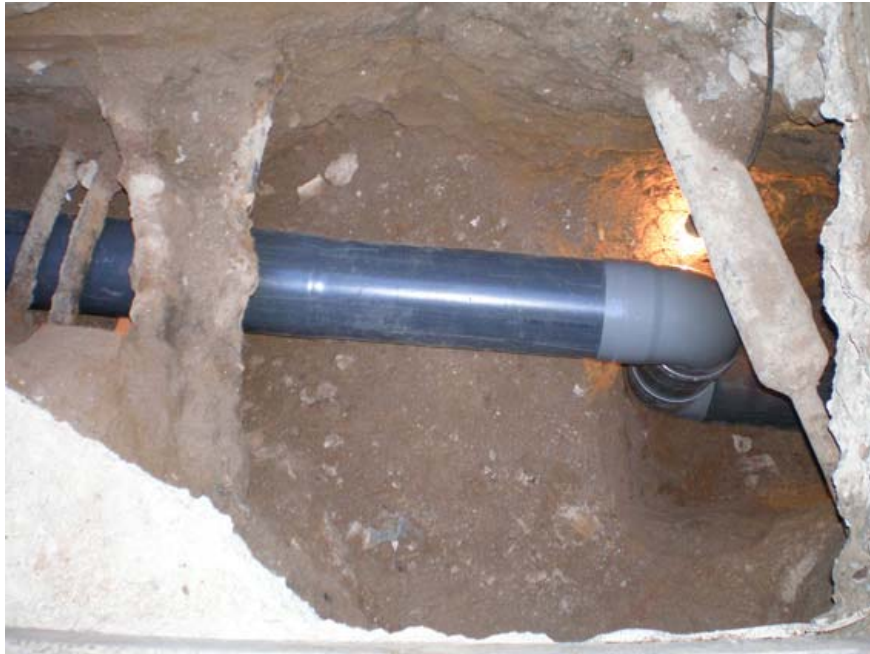
Detall de la rasa un cop col·locat el tub.
